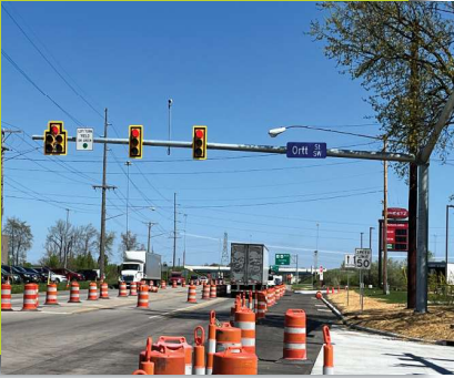
SR 21 (Erie Ave.) & Ortt St. SW New Sheetz Access Road Perry Township
